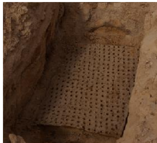
شکل ۲. نحوه کارگذاری صفحه‌های پلانت‌بک در چاله‌های حفر شده
